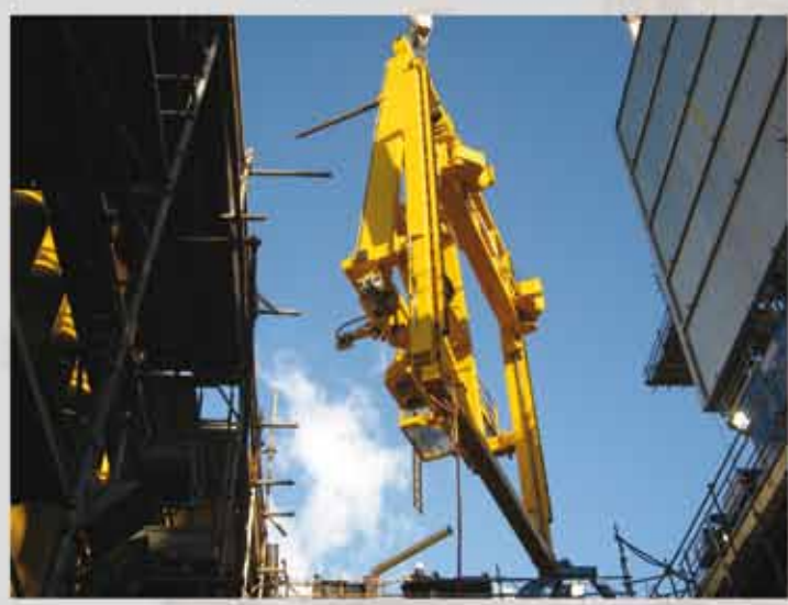
Installazione del "BOP Over Head Crane" a bordo della piattaforma di trivellazione SAIPEM "SCARABEO 8" (Fincantieri Palermo)
