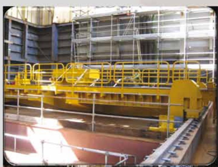
Installazione del "Baseplate Trolley" a bordo della piattaforma di trivellazione SAIPEM "SCARABEO 8" (Fincantieri Palermo)
